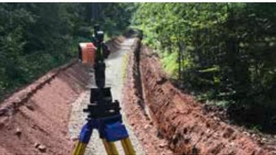
Um den Funkturm und die Gaststätte auf dem Hahnenkamm ans Alzenauer Stromnetz anzuschließen, ließ die EVA ein 2600 Meter langes Erdkabel durch den Wald über Kälberau verlegen.
