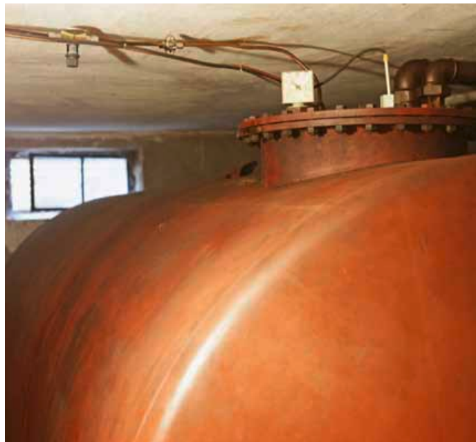
Wenn der 10000 Liter fassende Öltank erst einmal entsorgt ist, entsteht reichlich Platz. Die frei werdenden rund 15 Quadratmeter können die Eigentümer zum Beispiel als Fahrradkeller nutzen.
