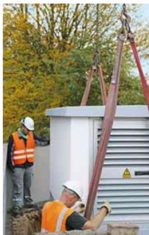
Weil die neue Station in einem Wasserschutzgebiet steht, ist die übliche Kühlung des Transformators mit Öl nicht zulässig. Folgerichtig ließ die EVA einen sogenannten Gießharztrafo per Schwerlastkran einschweben, der Mitte Oktober punktgenau in seinem Fundament landete.
