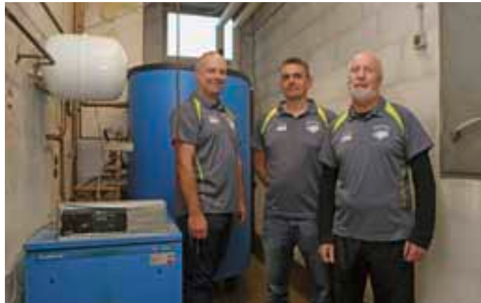
Jugendleiter Martin Heyde sowie die Vorstände Jörg Ries und Hans Zirkel (von links) freuen sich auf die neue Erdgasheizung
