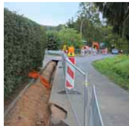
Die Erschließungsarbeiten der EVA beschränkten sich nicht auf die Ortsdurchfahrt
