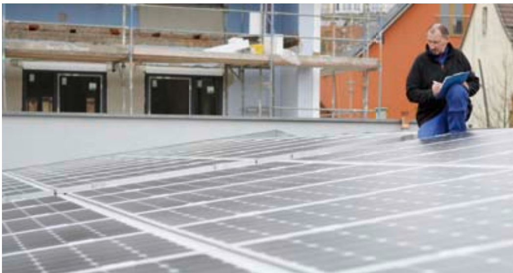
Markus Noll, Elektromeister aus Alzenau, hat die Fotovoltaikanlage der EVA geplant. Die Module auf dem Dach des Nebengebäudes hat er bereits installiert, die Module auf dem Dach des Hauptgebäudes folgen im Zuge der Bauarbeiten.
