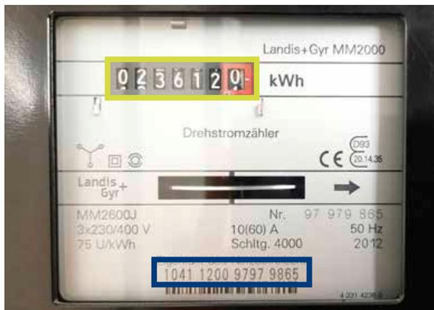
Elektromechanischer Stromzähler (Ferrariszähler)
