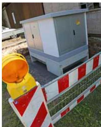
Bei den Dörsthöfen installiert die EVA eine neue kompakte Trafostation
