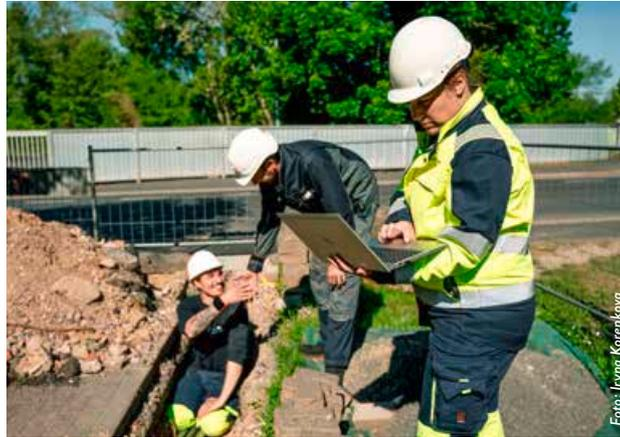
In der Kernstadt lässt die EVA Gasleitungen aus Stahl durch moderne PE-Leitungen ersetzen.
