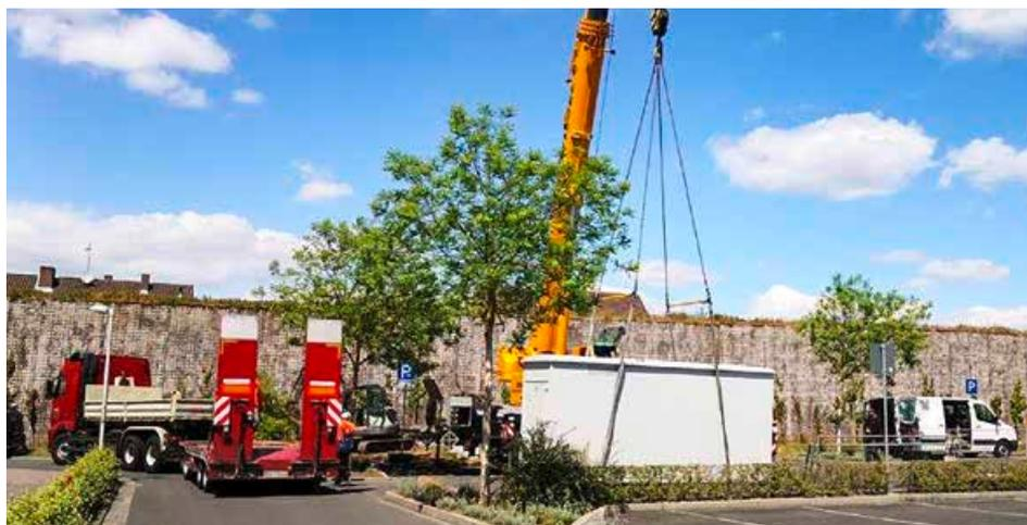
Auf den Zentimeter genau lässt der Schwerlastkran die neue Ortsverteilstation auf ihr Fundament ab.
