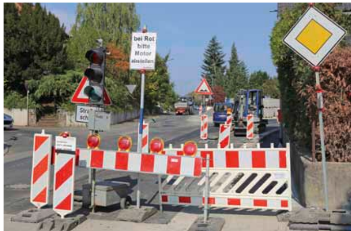
Wie üblich nutzt die EVA auch in Michelbach ohnehin anstehende Arbeiten am Kanal, um Leerrohre für Glasfaserkabel zu verlegen
