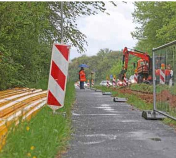
Zwischen den Stadtteilen Kälberau und Michelbach hat die EVA eine neue Erdgasleitung verlegen lassen. Diese zusätzliche Verbindung dient der Versorgungssicherheit. Denn sie stellt einen sogenannten Ringschluss dar. Das bedeutet, dass die EVA jetzt von zwei Zugängen aus Erdgas ins Netz von Michelbach und nachfolgend nach Albstadt bringen kann.
