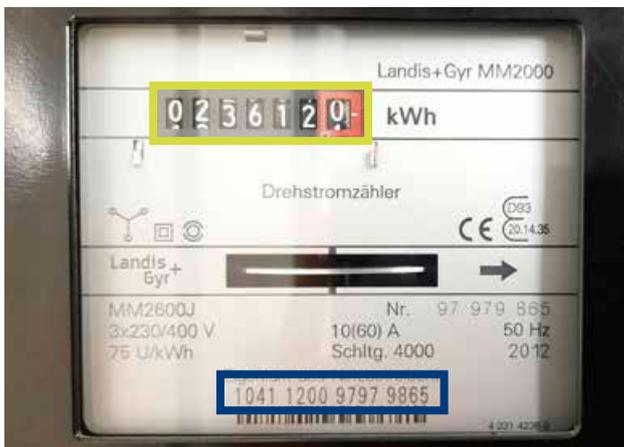
Elektromechanischer Stromzähler (Ferrariszähler)
