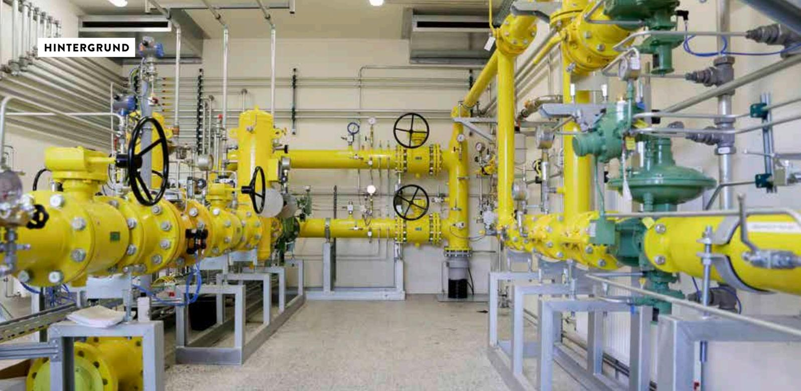
Neu, deutlich leistungsfähiger als ihr Vorgänger und vorbereitet für den Betrieb mit Wasserstoff: die neue Erdgasübernahmestation der EVA in Wasserlos.
