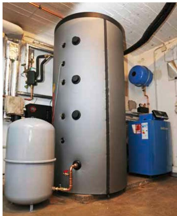
Der große Speicher lässt schon vermuten, dass es nicht beim effizienten Brennwertgerät bleibt. Im April folgt die Solarthermieanlage.
