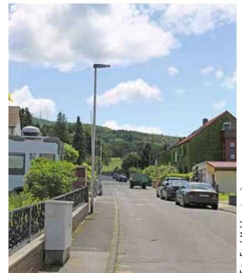
Während der Sommerferien lässt die EVA Erdgasleitungen in der Bergstraße in Michelbach verlegen.
